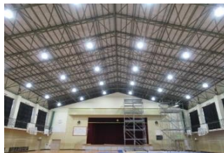
【中学校体育館へのLED照明導入】
